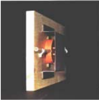
Abb. 20 Eingebaute Hohlwanddose, rückseitig gegen Herausreißen gesichert und abgedeckt
